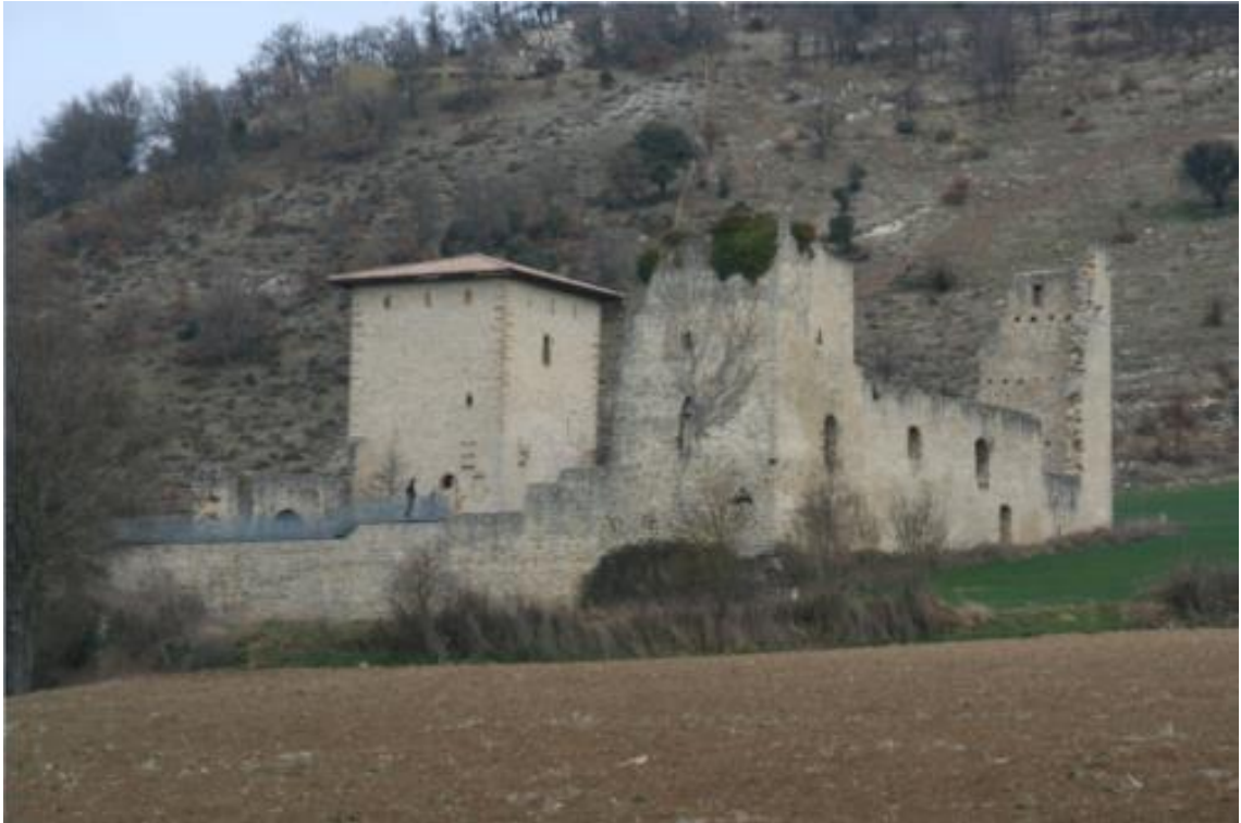
TORRE-PALACIO DE LOS GUEVARA
