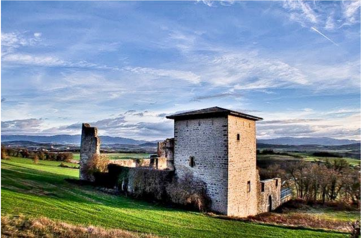
TORRE-PALACIO DE LOS GUEVARA
